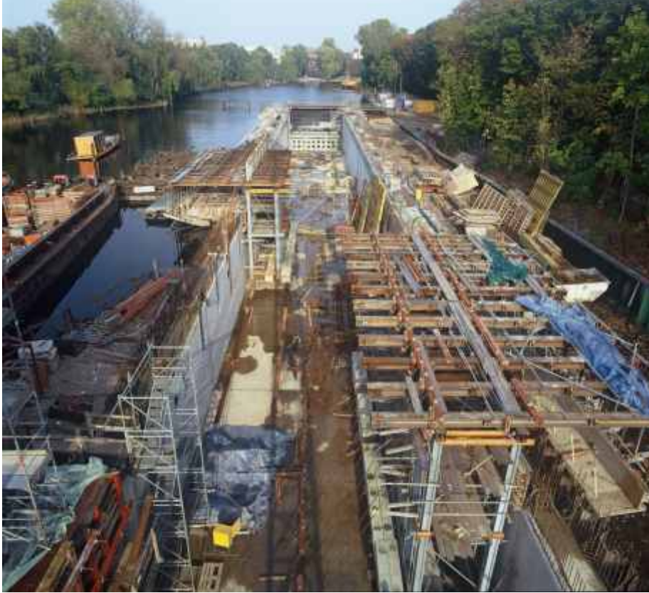
Schleusenammer im Bau, Blick aus dem Betriebsgebäude
