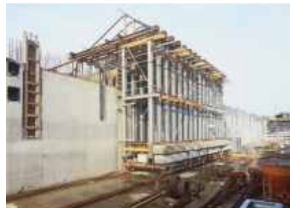
Schalgerüst für den Holm der Schleusenammer
