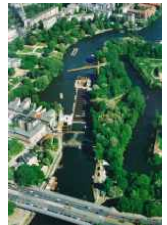
Luftbild: Schleuse im Bau, rechts Zitadelle Spandau
