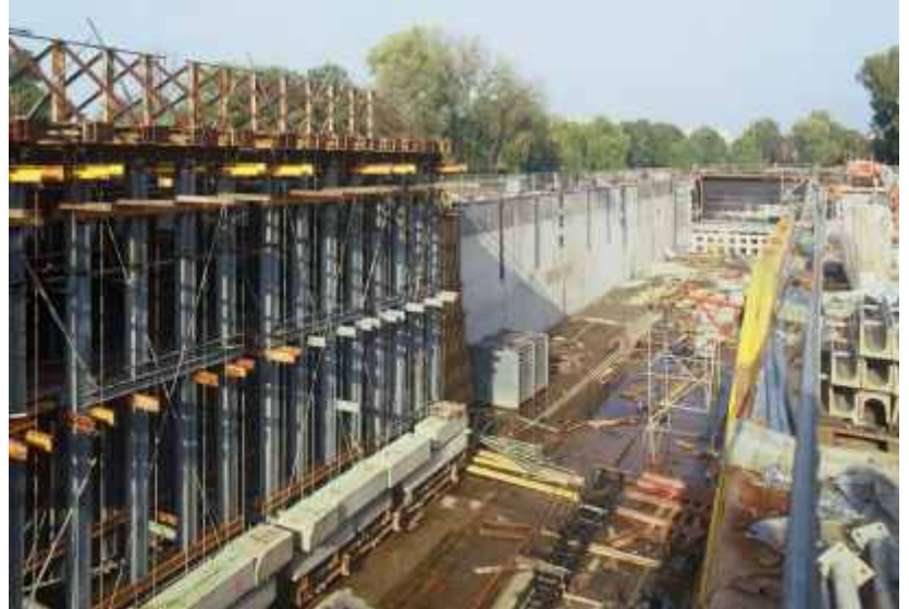
Schleusenammer, Blick auf das Oberhaupt
