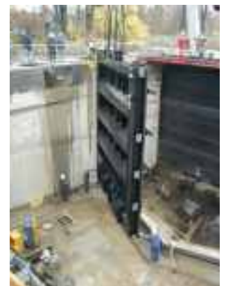
Einbau Stemmtor Unterhaupt
