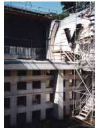
Lager des Segmenttores Oberhaupt
