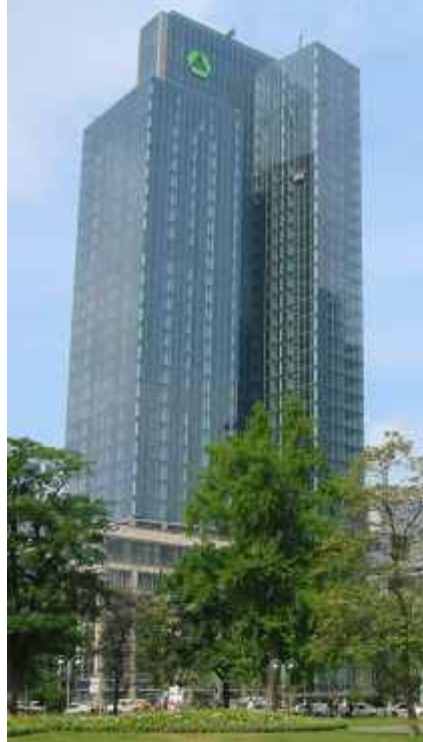
Вид на Галлилео со стороны Галлусанлаге
