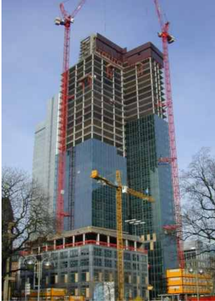
Незадолго до монтажа последнего перекрытия
