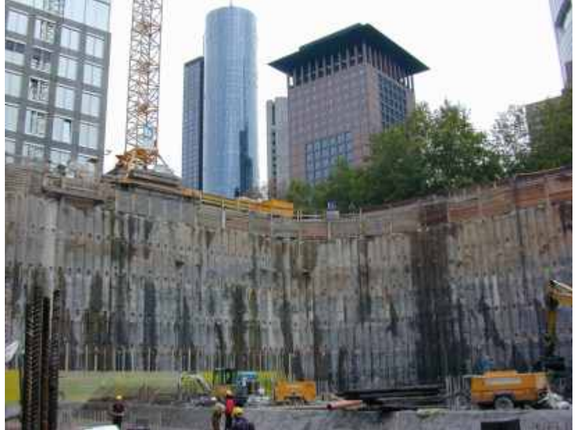
Der Verbau der Baugrube
