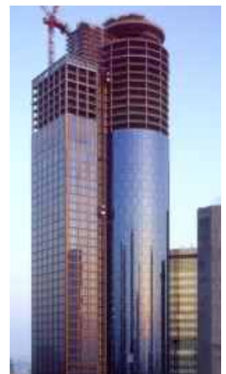
Der Main Tower während der Fassadenmontage
