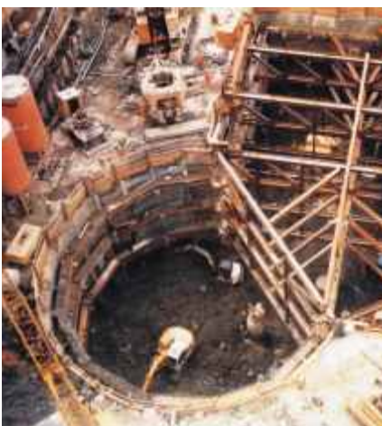
Blick in die Baugrube
