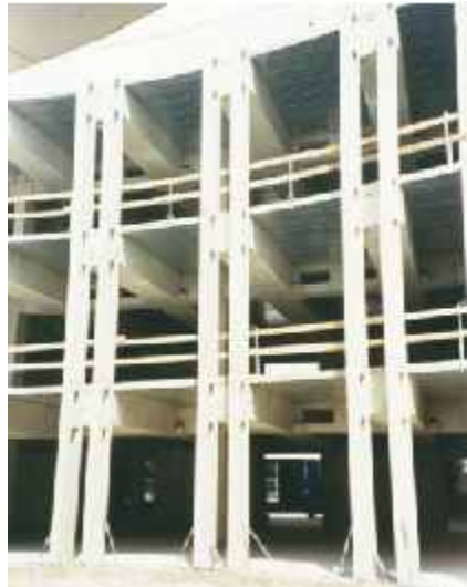
Fassadenstützen im Rohbau
