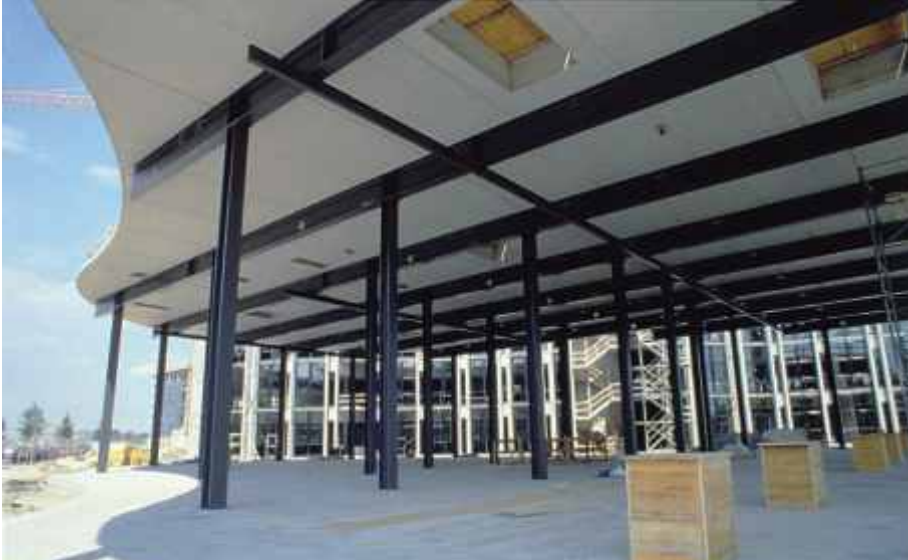
Konstruktion der Halle
