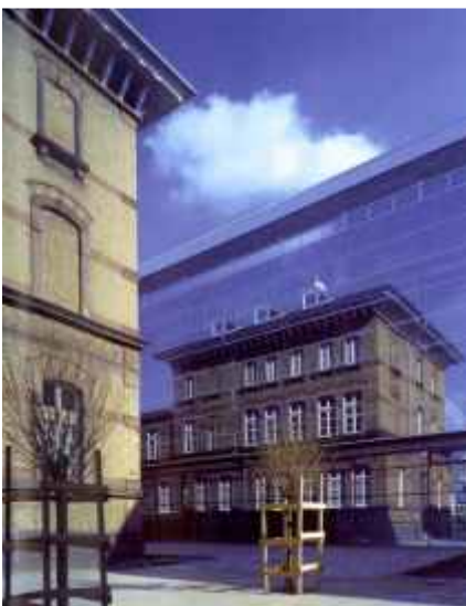
Spiegelung der alten Backsteinvillen in der begehbaren Glasfassade des fünfgeschossigen Verwaltungsneubaus
