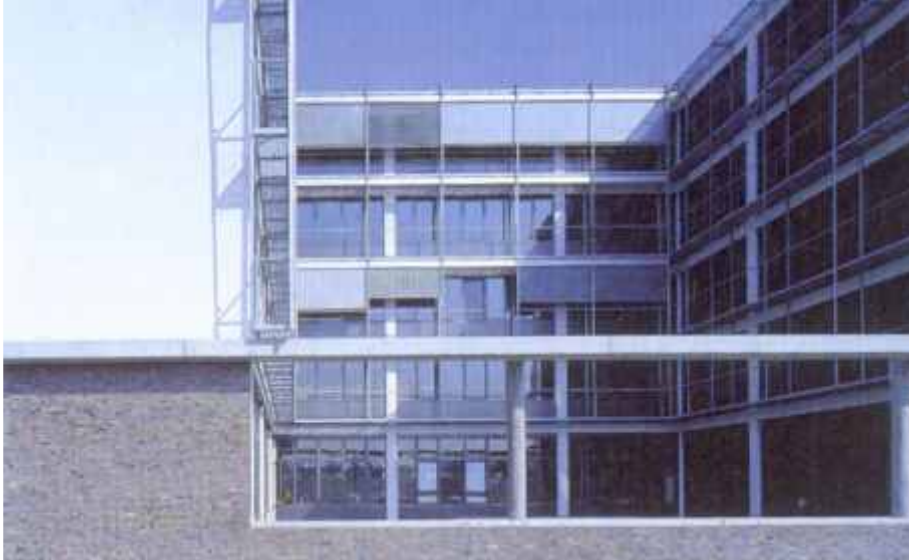
Blick in einen der vier Lichthöfe mit laufenden Fluchtbalkonen vor der Gebäudefassade
