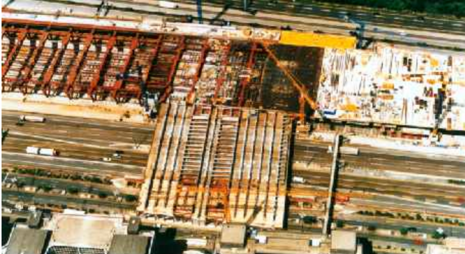
Luftaufnahme Überbauung BAB 3 und Fernbahnhof Flughafen Frankfurt
