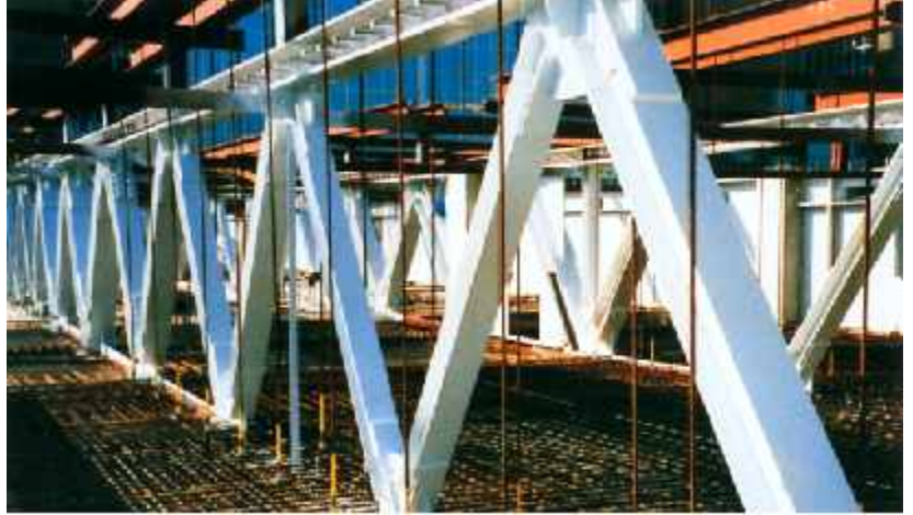
Technikebene: Geschosshöhe Fachwerkträger und untere Decke
