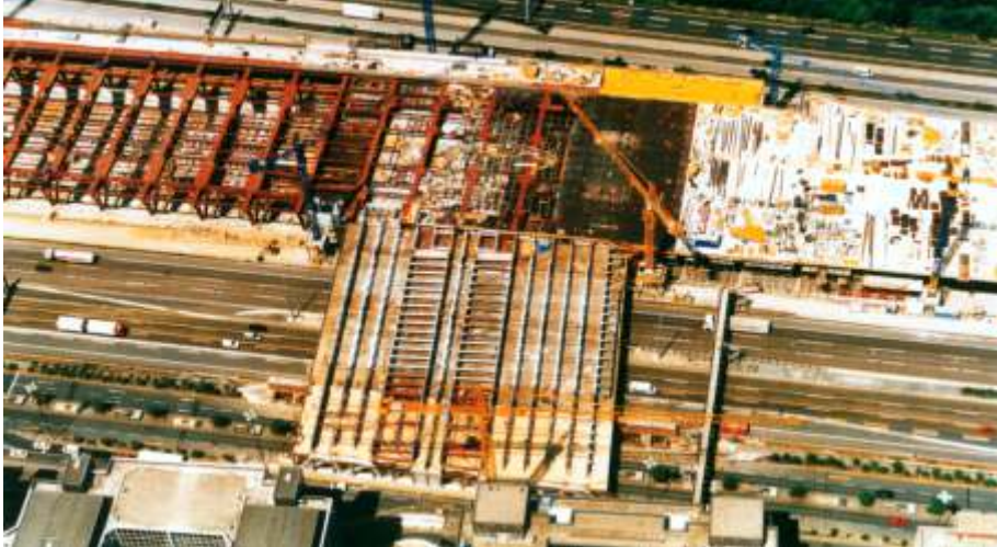
Luftaufnahme Überbauung BAB 3 und Fernbahnhof Flughafen Frankfurt
