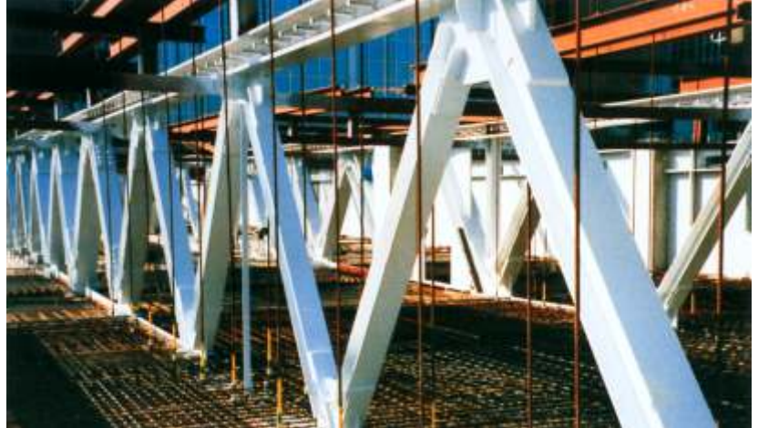
Technikebene: Geschosshöhe Fachwerkträger und untere Decke
