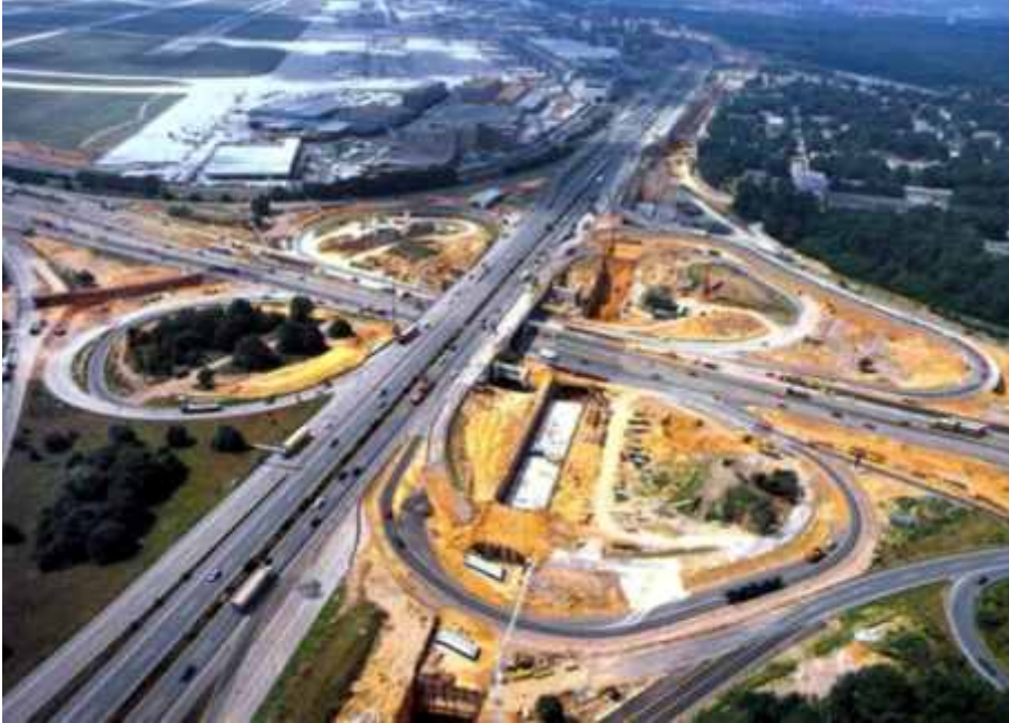
Tunnel für die Neubaustrecke unter dem Frankfurter Kreuz während der Bauphase
