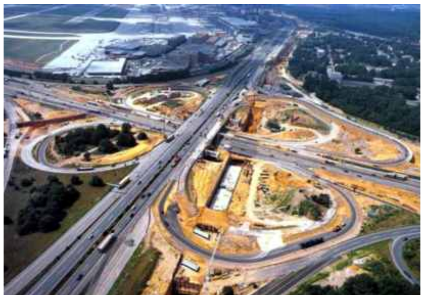
Neubaustrecke unter dem Frankfurter Kreuz während der Bauphase
