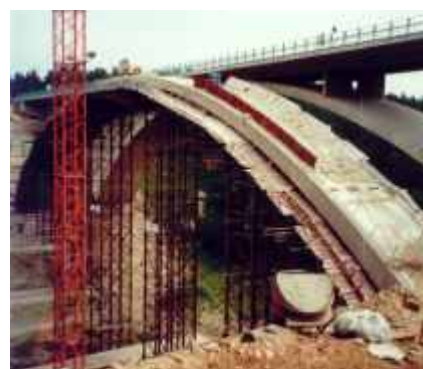
Abbruchgerüst südlicher Bogen vor dem Abbruch
