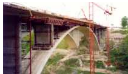
Überbauherstellung Lückenschluss
