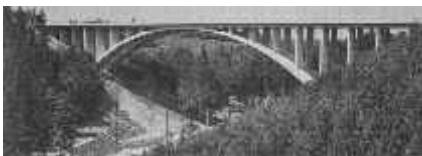
Vorhandene Brücke (Baujahr 1938/39)
