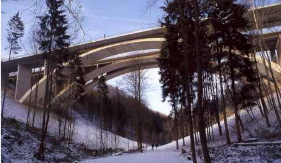
Neue (vorne) und alte Teufelstalbrücke
