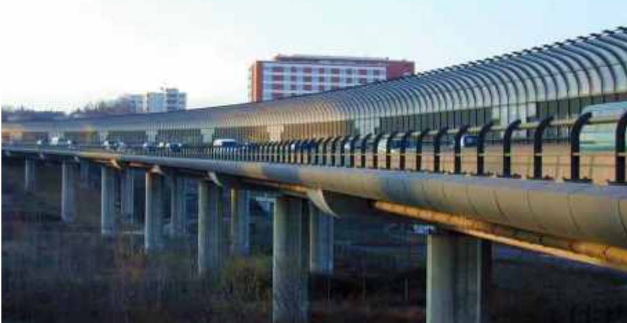
Gewölbte Lärmschutzwand auf der Talbrücke Seckbach (KB 240 A)
