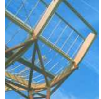
Auflagerung der Holzleimbinder auf Baumstütze
