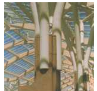
Auflagerung der Baumstützen
