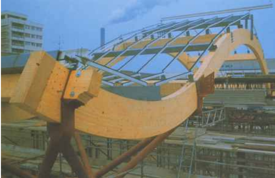
Holzleimbinder mit Glasunterkonstruktion
