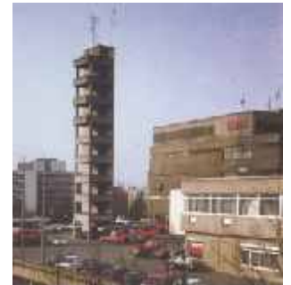
Feuerwehrhof und -turm
