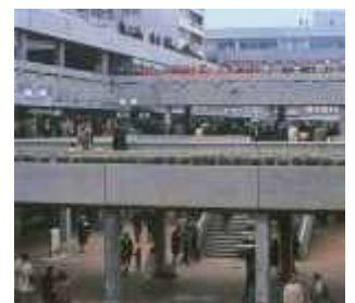
Große Mall vor dem Umbau
