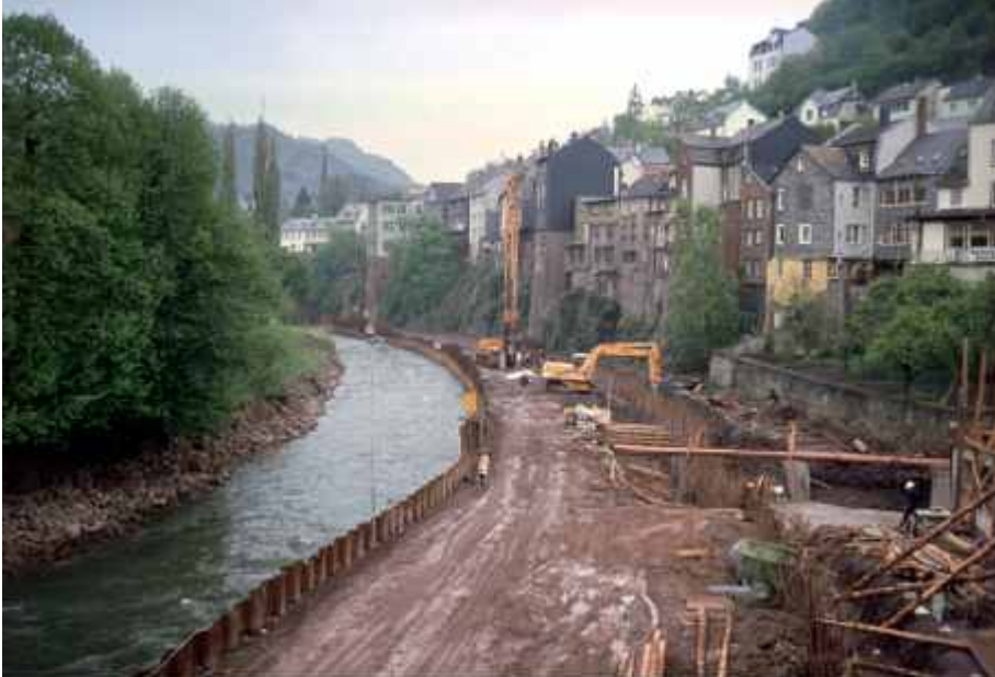
Bauzustand: Wasser (links) und Bauen (rechts)
