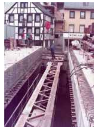
Aushub der Traggerüstträger in Schlusslücke
