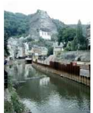
Bauzustand Nahe (links) und Bauen (rechts)
