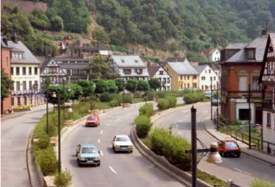
Neue B 41 / Naheüberbauung
