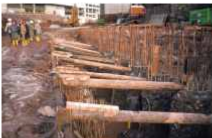
Ausgesteifte Baugrube für die Pfahlkopfplatte
