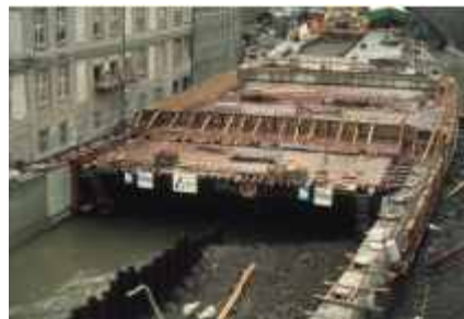
Oberstromiger Beginn der Überbauung
