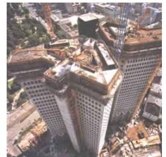
Die Zwillingtürme während der Bauphase
