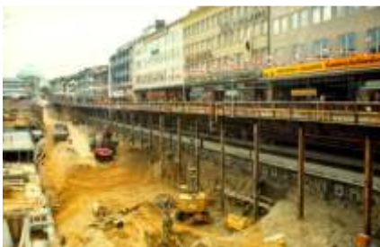
Gebäudeabfangung und aufgeständerter Fußgängerweg zu den Läden in der Wilhelminenstraße
