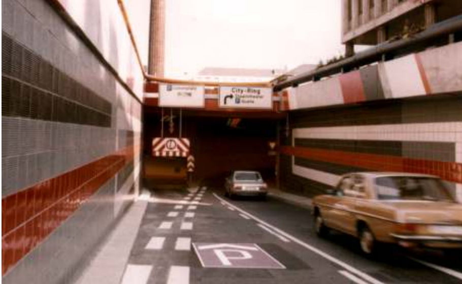
Seitliche Zufahrt in Tunnel und Parkdeck von der Rheinstraße
