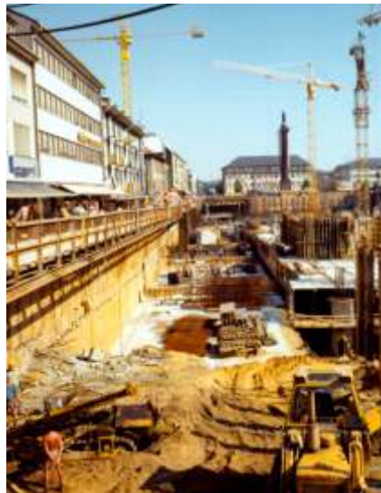
Erstellung der Tunnelbauwerke in offener Bauweise
