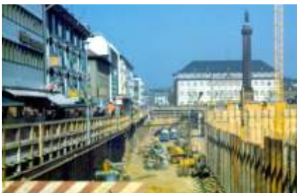
Die gesamte Wilhelminenstraße ist eine Baugrube
