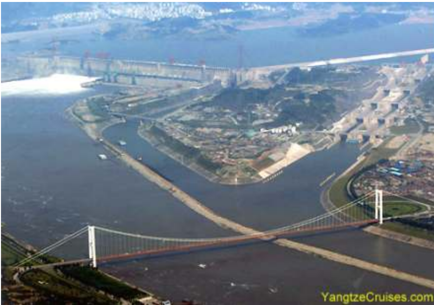
Ansicht der Gesamtanlage
