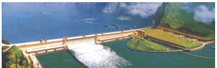
Der Drei-Schluchten-Staudamm in der Computervisualisierung: In der Bildmitte befindet sich die Staumauer mit den Wasserkraftwerksanlagen, ganz rechts die zweizügige Schleusentreppe für die Frachtschifffahrt und links davon das Schiffshebewerk für die Passagierschiffe.
