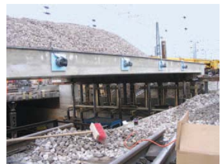
Bild 7. Überbau vor der Absenkphase
