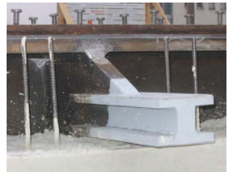
Bild 6. Detail Kopplung vor Betonierzustand
