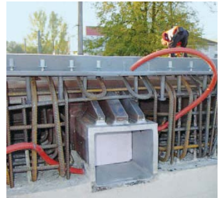
Bild 5. Detail Kopplung vor Betonierzustand
