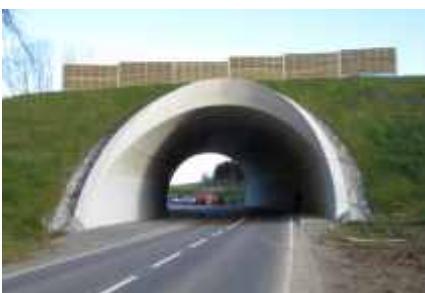
Westportal Bauwerk K 8025
