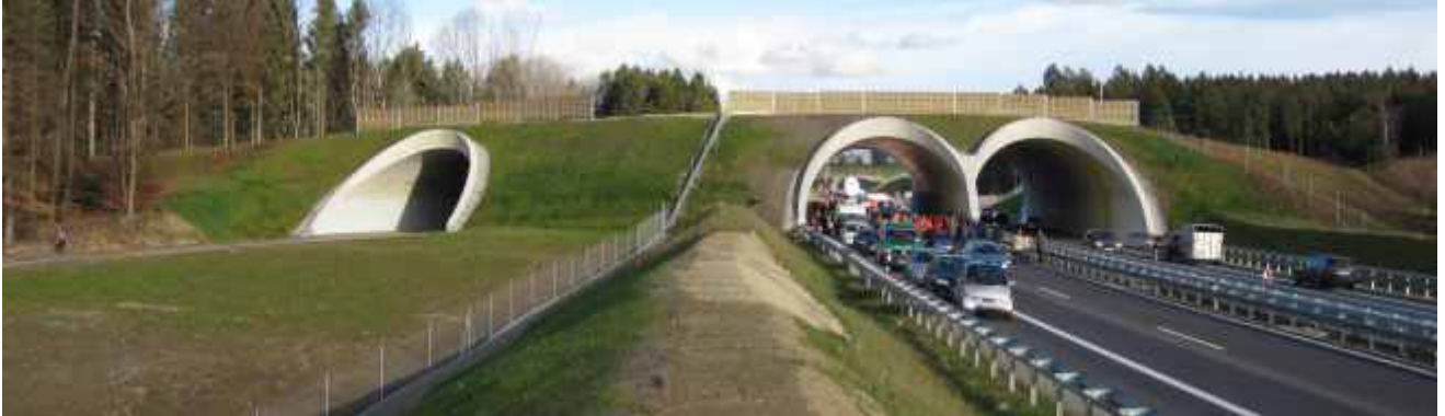
Westportal Bauwerk A 96 und Bauwerk K 8025
